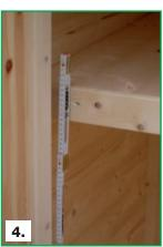
Zur Fixierung außen mittig anschrauben (Mit beiliegenden Schrauben befestigen). (Abb. 5 - 6)
