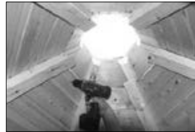
Dachhaube von innen mit Schrauben befestigen
