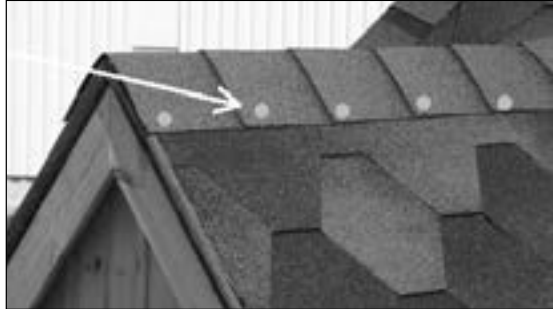
Schindel mit Dachpappennägel befestigen
