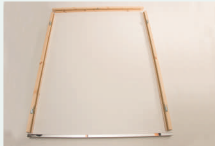
2. Positionieren der Rahmenteile
