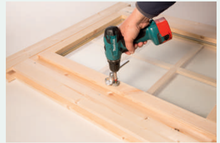
6. Anschrauben / Montage Fenstergriff
