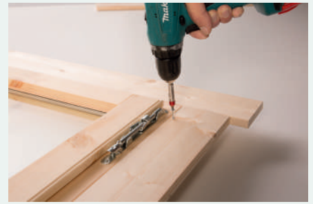
3. Anschrauben der Blenden
