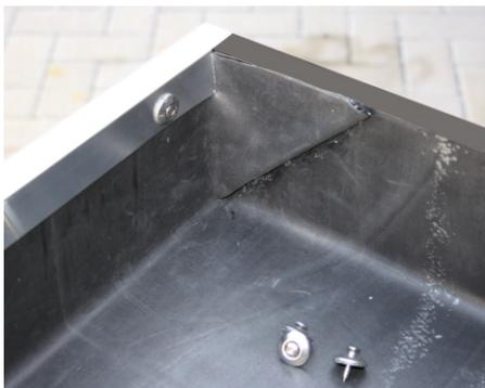
Am Längenstoß werden die Blendenabdeckungen ca. 4 - 5 cm überlappend gestoßen. Die 4 Ecken werden wie in den Fotos unten ausgeklinkt und übereinander gelegt.
