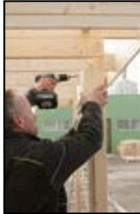
Anschraben der Führingleiste für Geschlossene Wand
