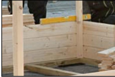
Kontrolle mit Wasserwaage ob in Waage
