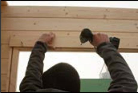
Befestigen vom Türrahmen mit den Türblindleisten aussen
