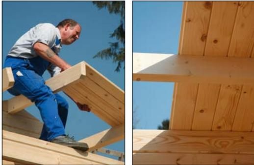
Achten Sie hier beim Verlegen auf einen gleichmäßigen seitlichen Überstand. Notfalls wird ein seitlicher durchgehender Versäuberungsschnitt nötig.
