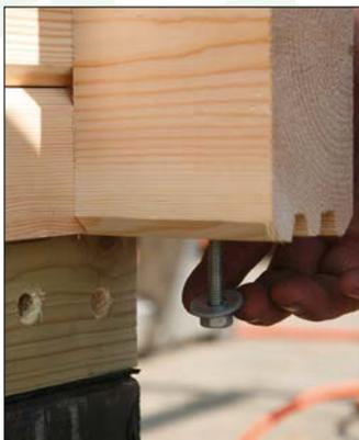
In die werkseitige ausgefrästen Aussparungen passen nun die Dachbalken
