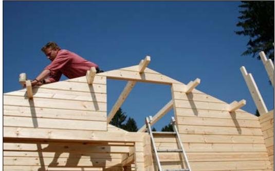
Die Balken werden einmal in der Länge „gestoßen“. Das heißt, ein besonderer Einschnitt, (siehe Abb.) ermöglicht eine Längsverbinding ...
