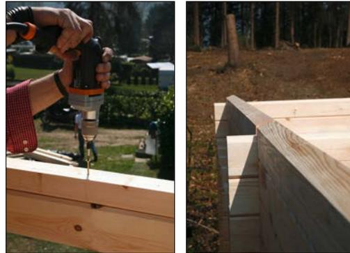
Die Giebel des Hauses bilden abschließend einen geschlossenen stabilisierten Ring um den gesamten Hauskorpus.
