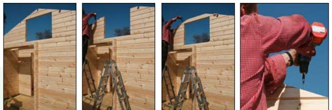
In allen Giebeln befinden sich nun die Aussparungen für die Lagerbalken, die im nächsten Schritt eingelegt werden können.
