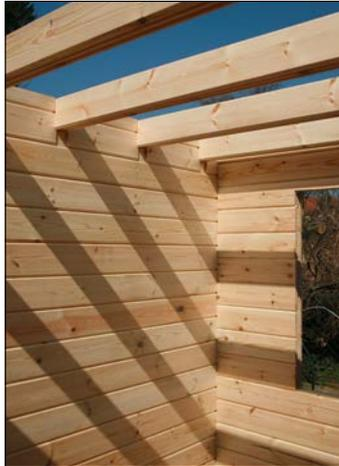
Die eingelegten Tragbalken für den Schlafboden sind so stabil in die Wandkonstruktionen eingelassen.
