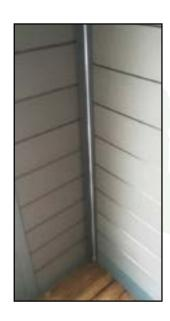
Achtung: Wir empfehlen von innen Winkelleisten mit Schlossschrauben als Sturmsicherung an der oberen sowie der unteren Aluminium-Bohle anzubringen.
