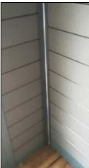
**Achtung: Wir empfehlen von innen Winkelleisten mit Schlossschrauben als Sturmsicherung an der oberen sowie der unteren Aluminium-Bohle anzubringen. Nicht im Lieferumfang enthalten!**
