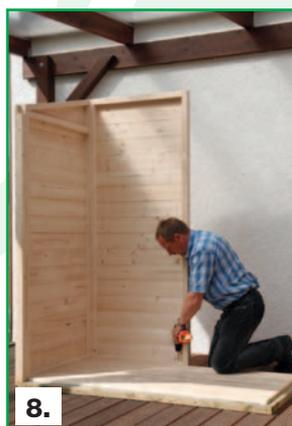
3. Zweite Rückwand ansetzen und mit Bodenplatte und erstem Rückwandelement durch die Rahmen verschrauben. **(Abb. 11 - 13)**
