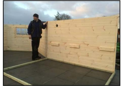
Wände auf Unterkonstruktion
