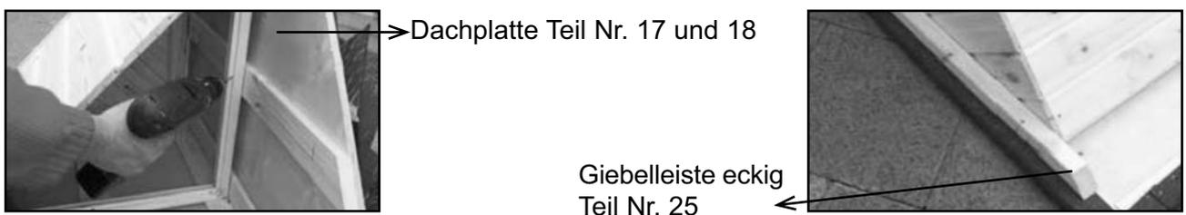
Stellen Sie nun die fertig montierte Gaube auf die Tür-Seitenblenden und verschrauben Sie die Gaube mit den Seitenblenden. Um das Spalten der Tür-Seitenblenden zu verhindern, empfehlen wir Ihnen die Schraubstellen vorzubohren. Zum Schluss wird die Gaube noch von der Hausinnenseite durch die Dachplatte und das Wandelement verschraubt. Verwenden Sie Holzschrauben 5×80.
