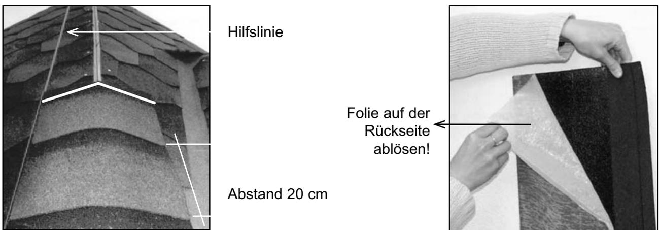
Legen Sie Schindel für Schindel im Abstand von 20 cm übereinander und befestigen Sie diese mit Dachpappnägeln. Wichtig, die Schindeln werden sichtbar an den Ecken genagelt. Dieser Vorgang wiederholt sich bis zur Dachspitze.
