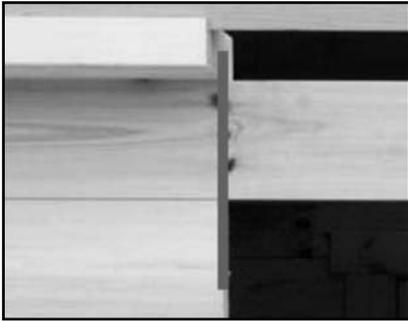
Vorgang Trennschnitt durch die Türtraverse. Linie gleich Schnittpunkt und Schnittrichtung!
