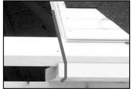
Vorgang Trennschnitt durch die Dachtraverse. Linie gleich Schnittpunkt und Schnittrichtung!
