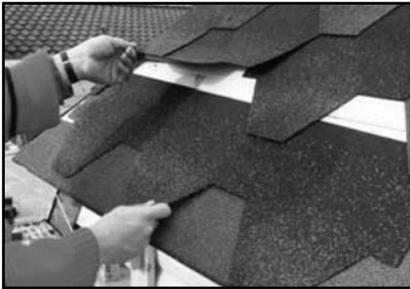
Schindel leicht anheben und nachfolgende darunter schieben und ausrichten.
