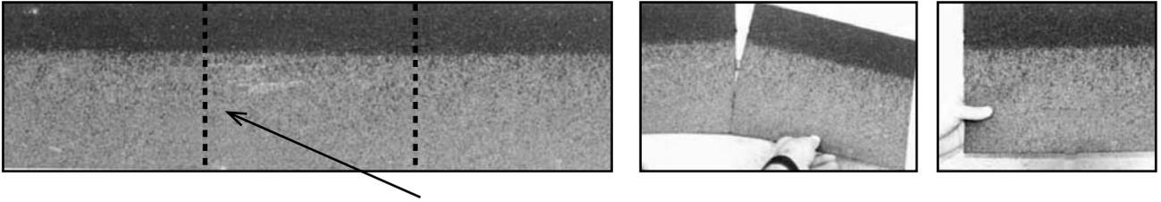
Falten Sie die Schindel entlang der Perforierung und trennen Sie diese ab. Sie erhalten dann die Einzelschindeln 33×25 cm, welche für den Dachgrat benötigt werden.
