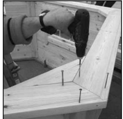
Zuerst alle Bretter über Wandabschluss verteilen, ausrichten und anschließend jede Ecke mit 1 Holzschraube 5x80 verschrauben.
