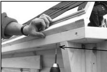
Schrauben Sie das Dachelement von unten an den oberen Wandkranz.
