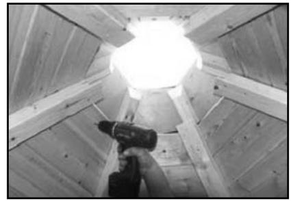
Dachhaube von innen mit Schrauben befestigen
