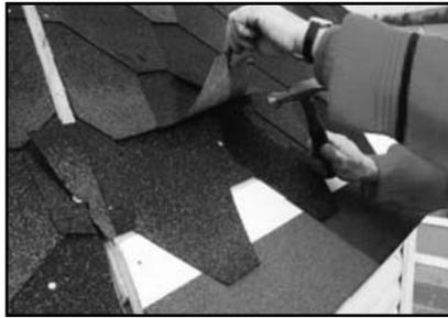
Befestigen Sie die Schindeln mit den mitgelieferten Dachpappnägeln. Sie benötigen pro Schindel 5 Nägel.
