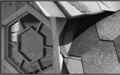
Schindel mit Dachpappnägeln befestigen
