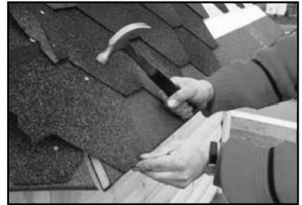
Achten Sie darauf, daß Sie seitlich genügend überlappen. An der Dachtraufe muß die Schindel bündig abschließen.
