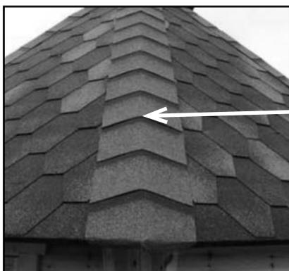
Ansicht Dachgrat fertig montiert
