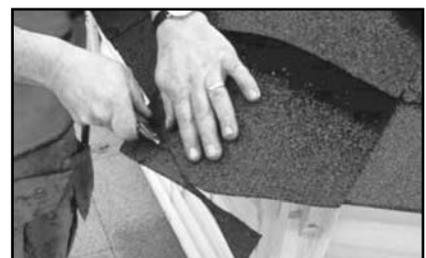
Zum Schluß wird die erste Schindel entlang der Dachtraufe abgeschnitten
