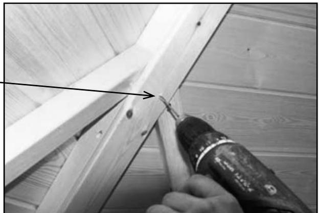
Nachdem Sie die inneren Dachleisten festgeschraubt haben, bauen Sie den Dachkranz an den Rauchabzug an und befestigen Sie ihn mit den Holzschrauben am Dach.
