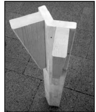
Montieren Sie die Eck-Stützhölzer von aussen bündig Oberkante an die Wand-Eck-Zierleisten. Verwenden Sie dazu Holzschrauben 5x80.
