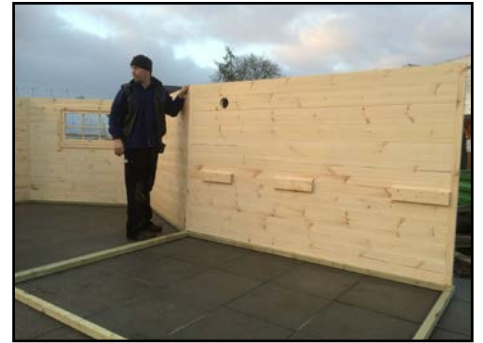
Wände auf Unterkonstruktion
